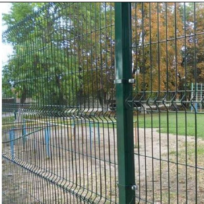
Технические параметры: Установка 3Д ограждения, толщина прутка 5 мм, столбы 80x80x2 мм на фланце, калитка 1x2м, оцинкованны, цвет зеленый
