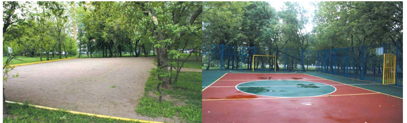
Ул. Полоцкая. Спортивная площадка до и после ремонта территории района Кунцево на 2012-2016 гг.
